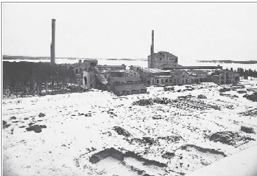
Luleå Järnverks AB (Karlsvikshyttan) under uppförande med den blivande bangården i förgrunden. Bilden är från 1905. Foto: Henny Tegström & Co. Luleå kommun Stadsarkivet
