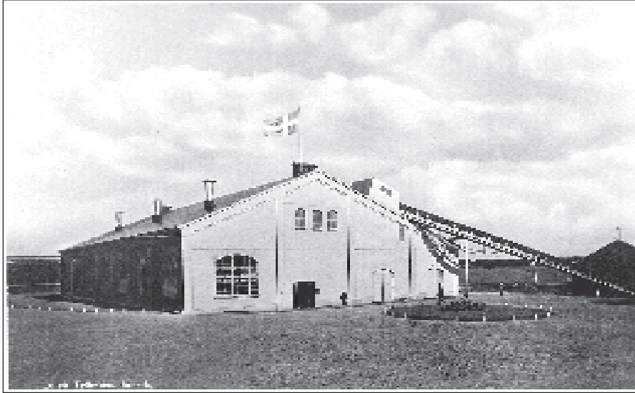
Luleå Trämassefabrik uppfördes 1911 - 1912. Huset rivet men grunden finns kvar
